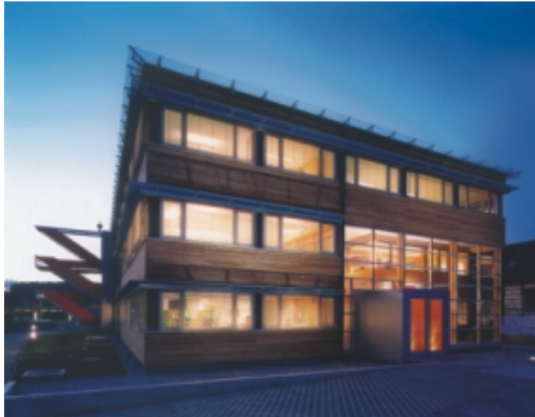
Abb. 1 - Süd- Ostansicht des W.E.I.Z.
