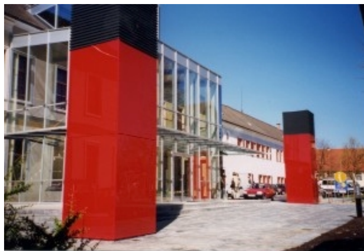
Abb. 4 - Luftansaugtürme für den Stadtsaal Gleisdorf
