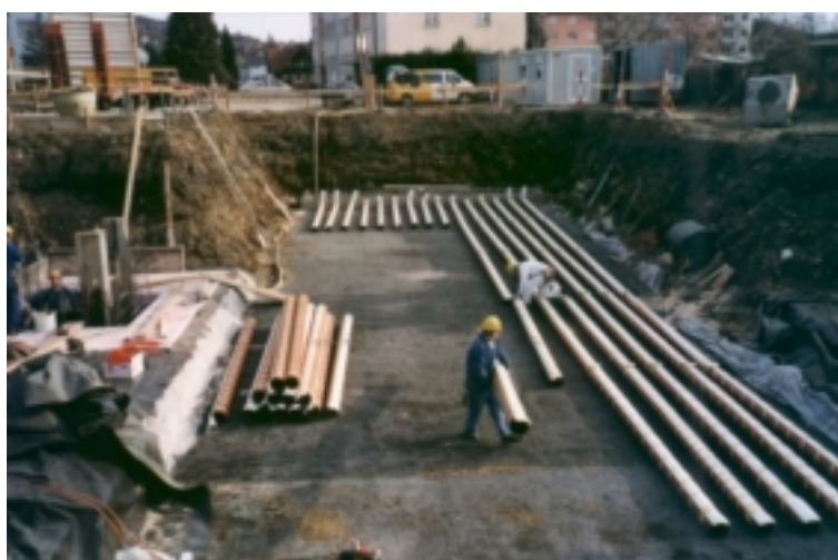
Abb. 2 - Verlegung der 15 parallelen PVC-Rohre unter der Fundamentplatte des Gebäudes
