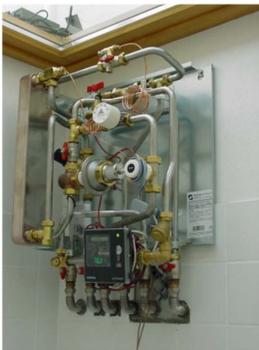
Abbildung 6: Vorinstallierte Wohnungsstation mit externem Wärmetauscher zur Brauchwassererwärmung und sämtlichen Komponenten für den Heizbetrieb inkl. Wärmemengenzähler (Produkt: Gemina-Termix, Bildquelle: GSWB, Salzburg).
