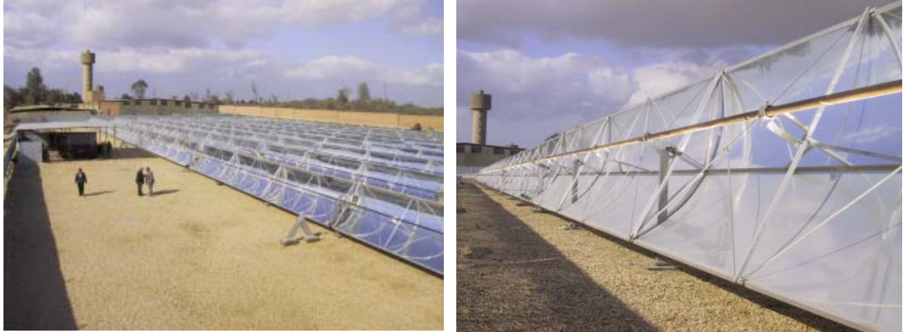
Abb. 5: 1900 m 2 Parabolrinnen-Kollektoranlage für „El NASR Pharmaceutical Chemicals“ in Ägypten (Foto: Fichtner Solar GmbH)
