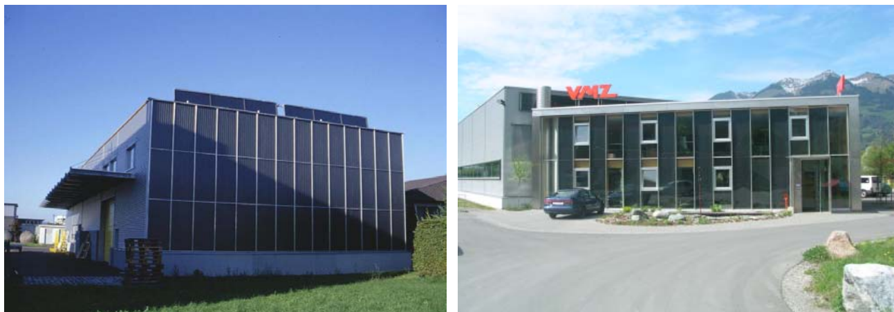
Abb. 7: Solaranlagen zur Beheizung von Produktionshallen. Links: Monovalent solar beheizte Halle der Firma Winkler. Rechts: Büro und Produktionshalle der Firma VMZ in Bludesch.
