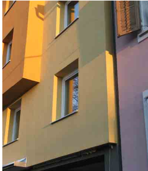
Gedämmte Wand nach der Sanierung (Quelle: Grazer Energieagentur)
