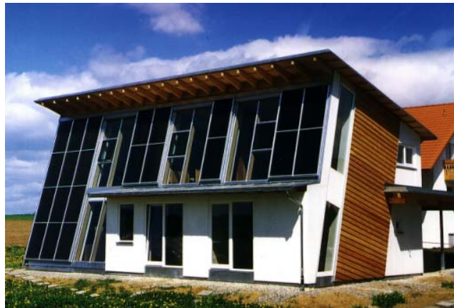
Abb. 1: Solare Kombianlage mit fassadenintegriertem Kollektorfeld (Quelle: Wagner & Co, Deutschland)
