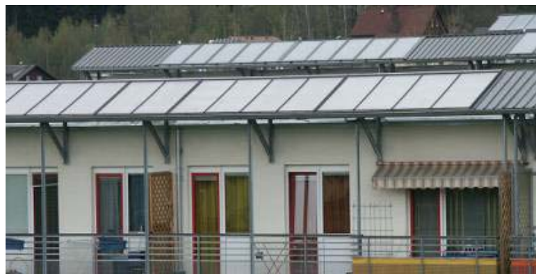
Fohnsdorf, Wohnpark West
