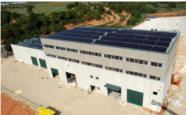
Ansicht der Contank Solaranlage
