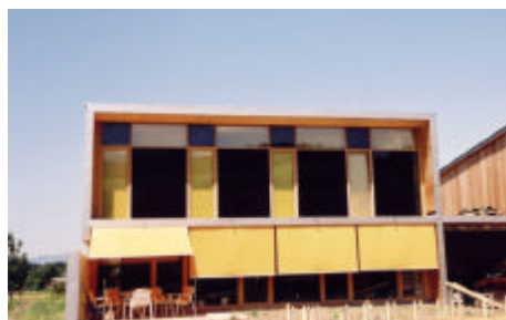
Abb.2: 28 m 2 Kollektorfläche in der Fassade eines Holzriegelbaus, Brauchwasserbereitung und Raumheizung. Die Glasabdeckleisten sind aus Holz.
