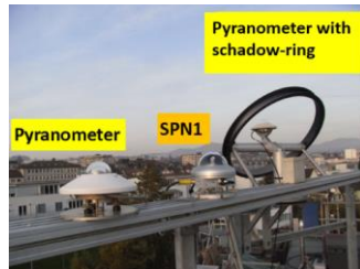
Var1: Pyranometer plus Schattenringpyranometer
