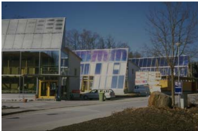
Abbildung 11: Südansicht der drei Gebäude
